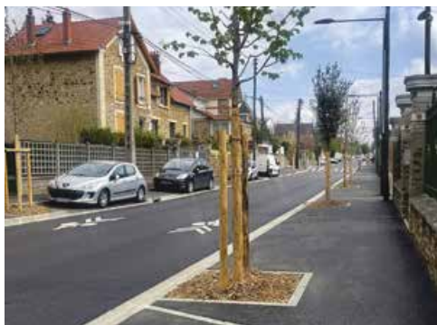
L'avenue Carnot après les travaux de réfection.
