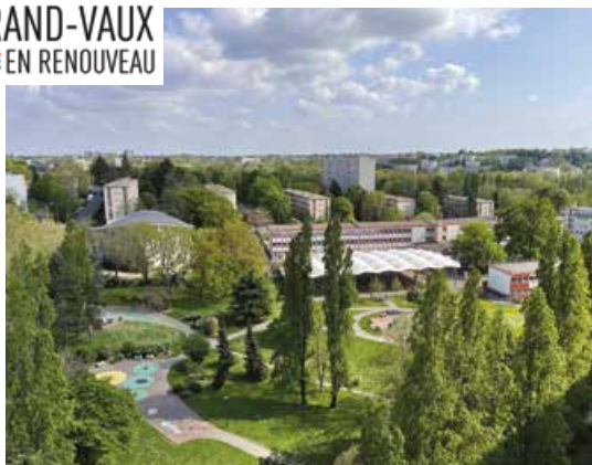
Vue aérienne du quartier de Grand-Vaux.
